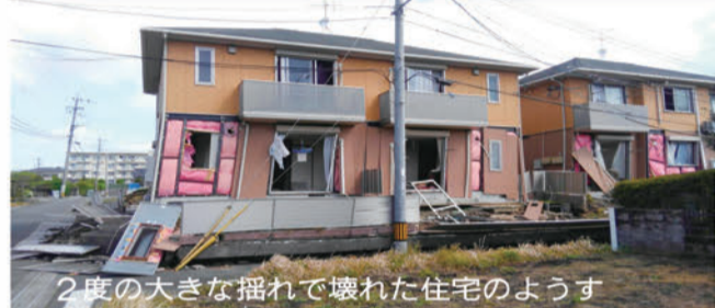
2度の大きな揺れで壊れた住宅のようす
