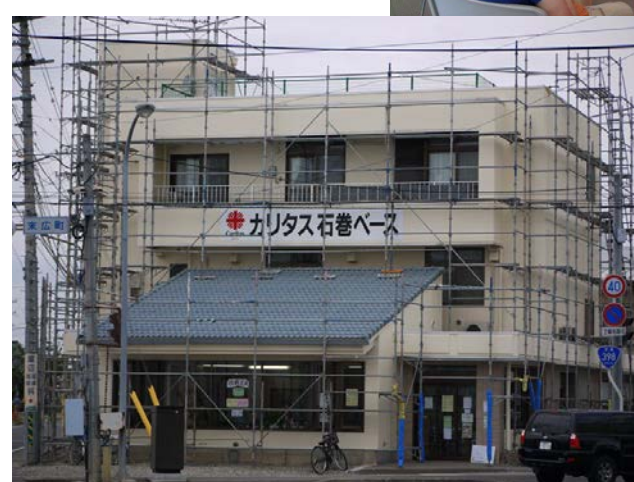
←外のブルーシートが 外された石巻ベース全景
